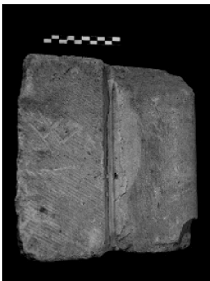
Fig. 5 : Objets n os 1137 et 1155, qui présentent une colonnette engagée en vue zénithale et en élévation. On remarque aisément sur la vue zénithale le développement asymétrique et différencié de la moulure à gauche et à droite de la colonnette. En élévation, la face taillée au moyen de ciseaux droits sans palette accueille un signe lapidaire d'identité en forme de fourche. Ce signe lapidaire est sans doute un des plus anciens retrouvés en Région bruxelloise lié à la pratique de construction ancienne.
