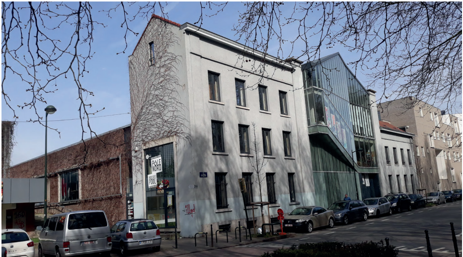
Fig. 3 - Façade de l'ancien Brussels Rinking.
